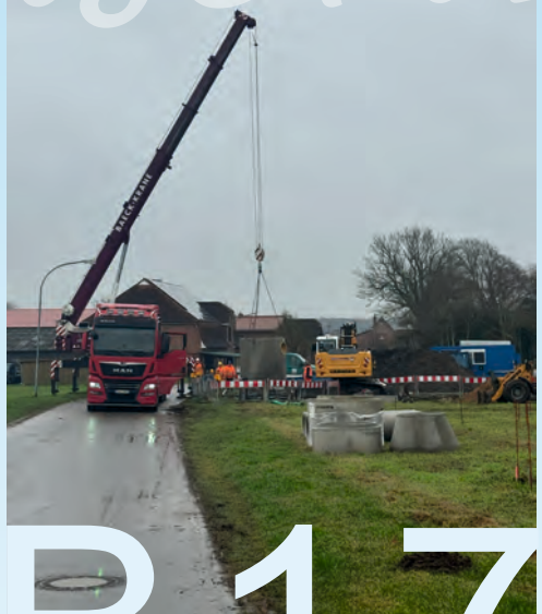
Abb.: Telekraneinsatz für Einbau Regenwasser- behandlungsanlage „Hydroshark“, 9. Dezember 2025
