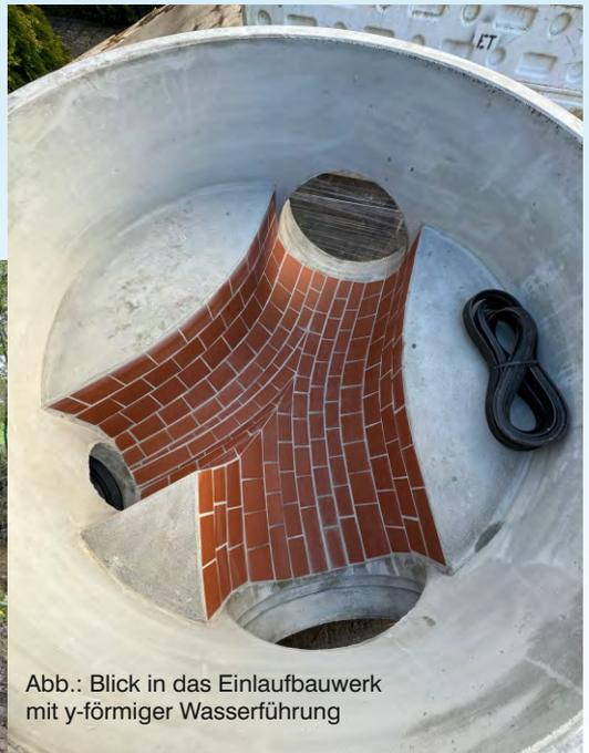
Abb.: Blick in das Einlaufbauwerk mit y-förmiger Wasserführung
