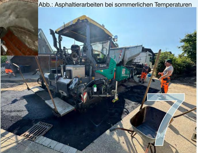
Abb.: Asphaltierarbeiten bei sommerlichen Temperaturen
